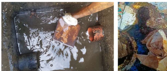
Gambar 5. Pembersihan Bangunan IPAL dan Bak Kontrol
